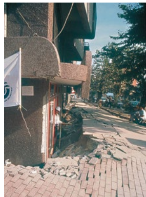
Abb. 6a und 6b: Bodenverflüssigung, Izmit 1999. Fotos: P. Lestuzzi, SGEB-Erkundungsmission
