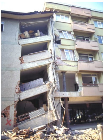
Abb. 5a und 5b: Aufeinanderprallen benachbarter Gebäude, Izmit 1999. Fotos: P. Lestuzzi, SGEB-Erkundungsmission
