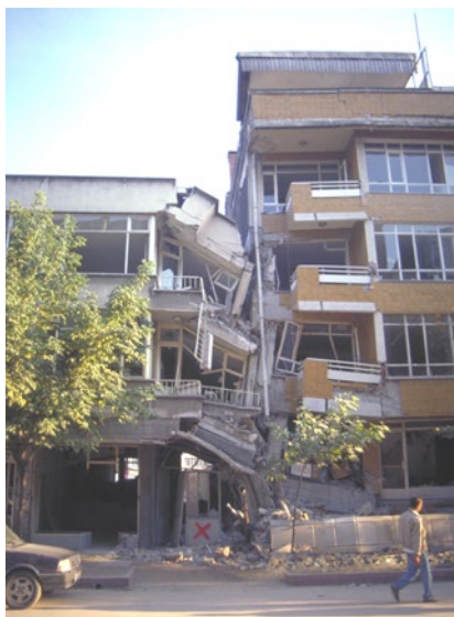
Abb. 5a und 5b: Aufeinanderprallen benachbarter Gebäude, Izmit 1999. Fotos: P. Lestuzzi, SGEB-Erkundungsmission
