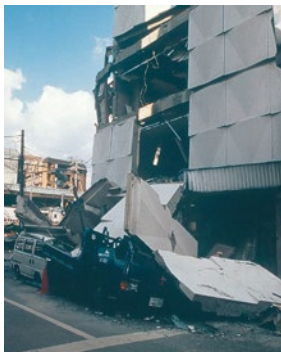
Abb. 4a und 4b: Heruntergefallene Fassadenelemente, Kobe 1995. Foto 4a: Architectural Institute of Japan, Foto 4b: T. Wenk, SGEB-Erkundungsmission
